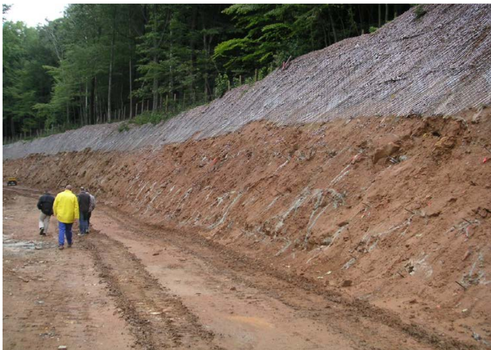
Fig. 3: Segunda fase de excavación hasta aproximadamente 0,60 m por debajo del nivel final de la calzada
