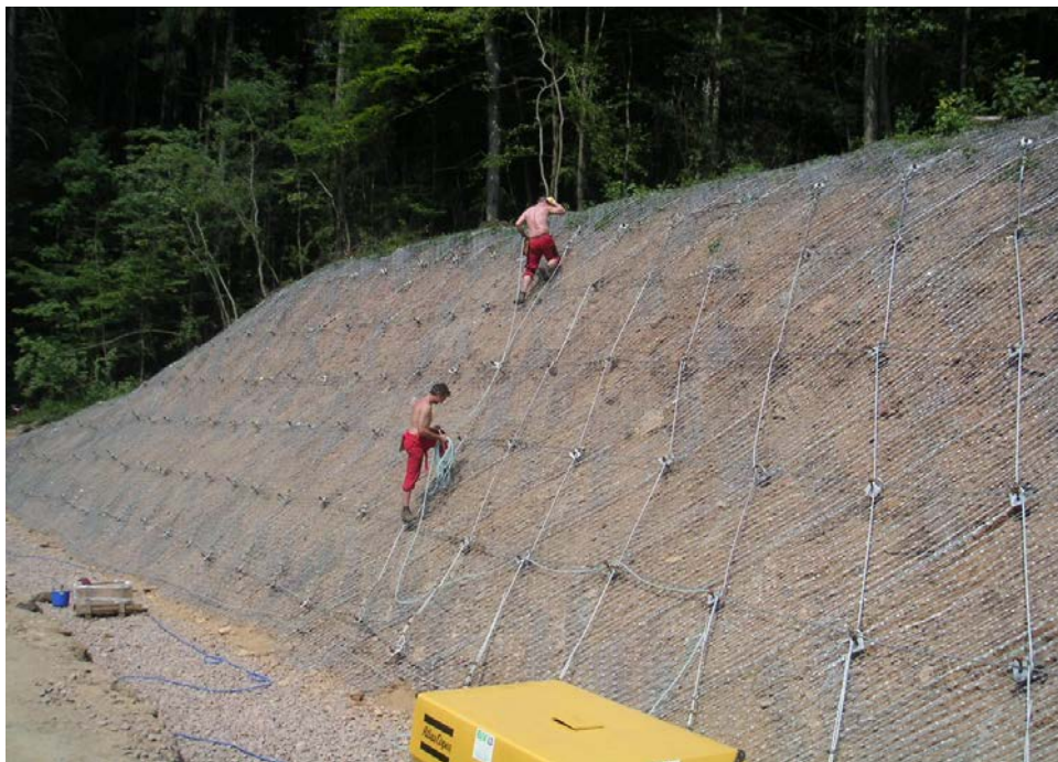
Fig. 5: Siguiendo la red de distribución de los anclajes, se instalan los cables tanto de forma horizontal como diagonal
