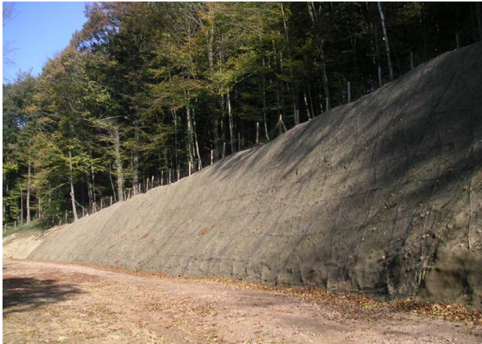
Fig. 9: Relleno de tierra vegetal completada. El relleno se realizó mediante proyección por vía seca con una gunitadora. Para impedir el lavado de finos hasta establecerse el sistema radicular de la vegetación, se recubrió toda la superficie con una malla de plástico con una luz de 10 x 10 mm. Esta malla también aumenta la protección del talud en el caso de inundaciones
