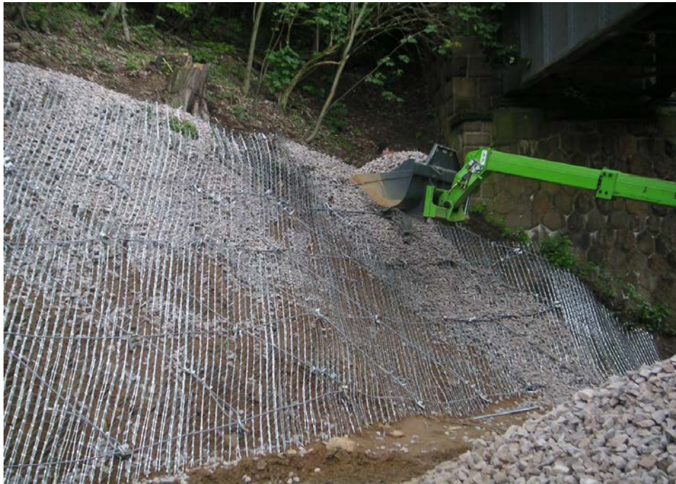
Fig. 6: Relleno de los paneles de la malla tridimensional volumétrica
