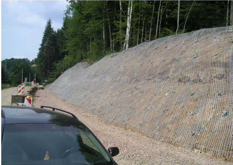
Fig. 4: Anclaje del Sistema Krismer® con soil nailing terminado
