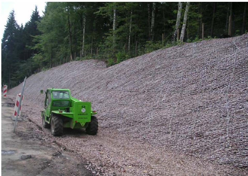
Fig. 7: Los paneles de malla tridimensional J.K.S. con el relleno de grava proporcionan drenaje y agarre para la capa de tierra vegetal
