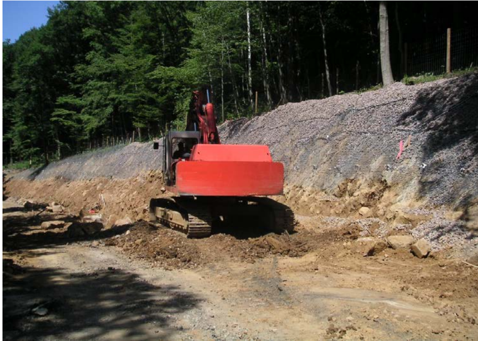
Fig. 2: Primera fase de excavación seguida inmediatamente por la instalación del Sistema Krismer® con soil nailing
