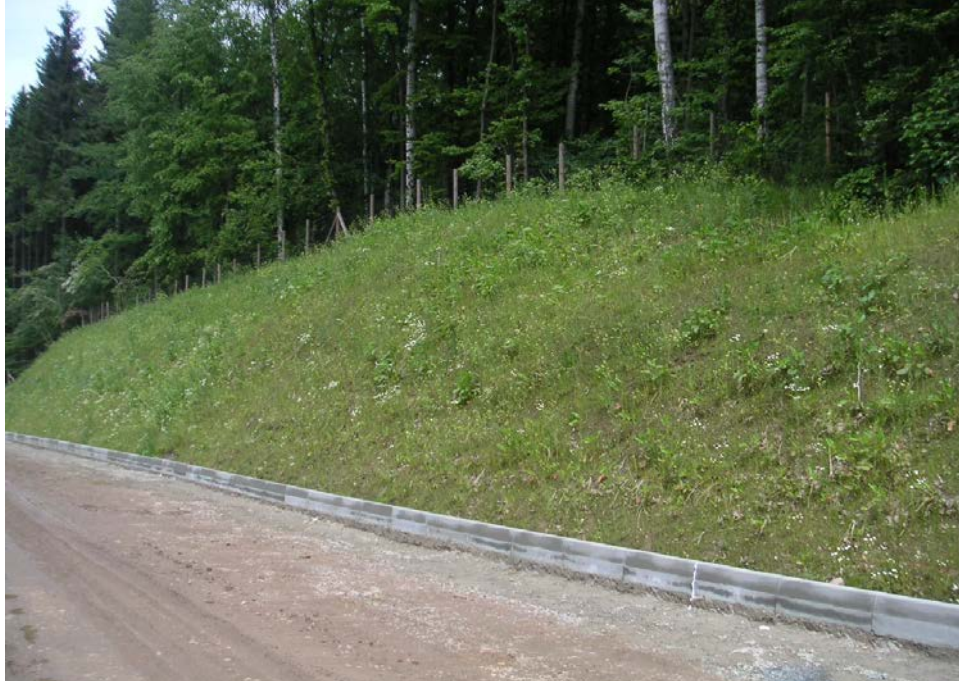
Fig. 13/14: Estado del talud tras el segundo año de crecimiento de la vegetación, en junio de 2006
