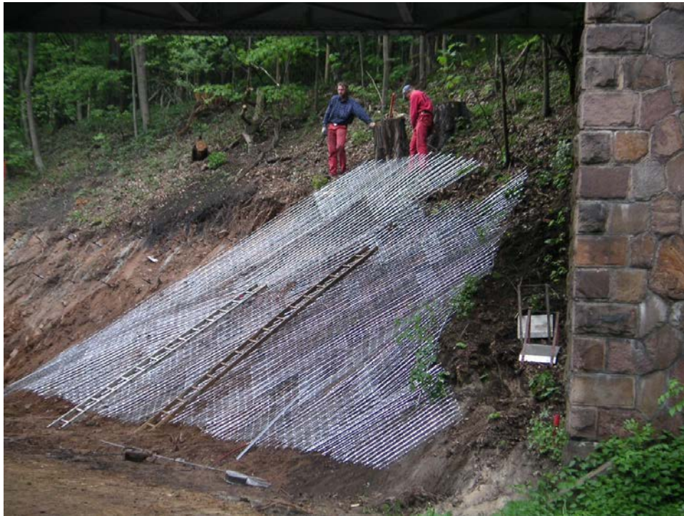
Fig. 1: Inicio de la instalación
