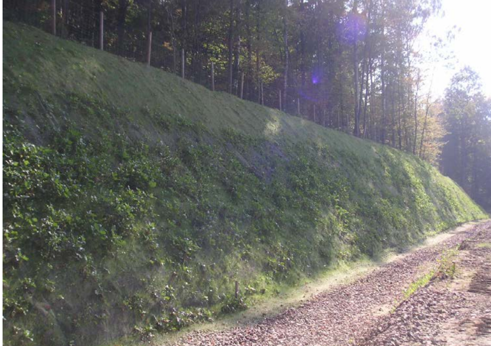
Fig. 11/12: El estado del talud aproximadamente un mes después de realizar la siembra, en octubre de 2005. Las semillas y los fertilizantes se mezclaron con la tierra vegetal durante la última fase de proyección (espesor 1 a 2 cm)
