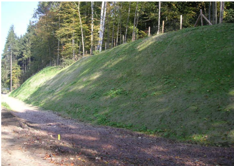
Fig. 11/12: El estado del talud aproximadamente un mes después de realizar la siembra, en octubre de 2005. Las semillas y los fertilizantes se mezclaron con la tierra vegetal durante la última fase de proyección (espesor 1 a 2 cm)
