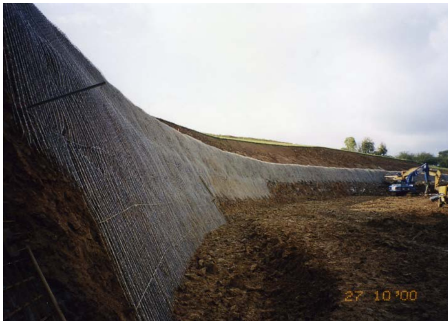
Fig. 2: Instalación del Sistema Krismer® en varias secciones y de forma simultánea a la excavación del talud
