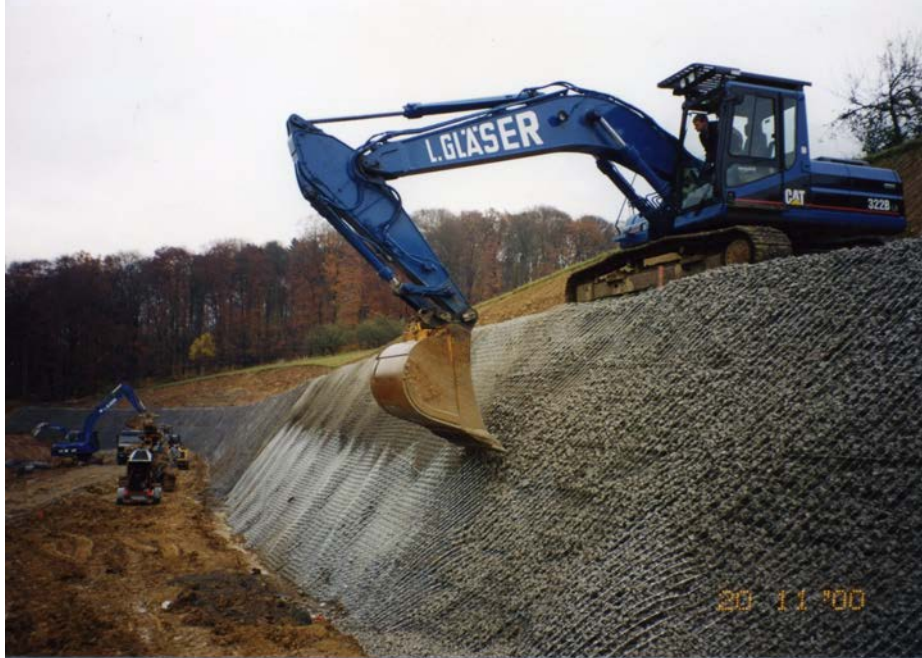
Fig. 4: Relleno de grava (tamaño: 32/60 mm)
