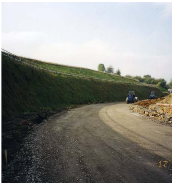
Fig. 7-8: El talud estabilizado con el Sistema Krismer®: a 1 año de terminar la instalación (izq.) y a los 6 años (dcha.)
