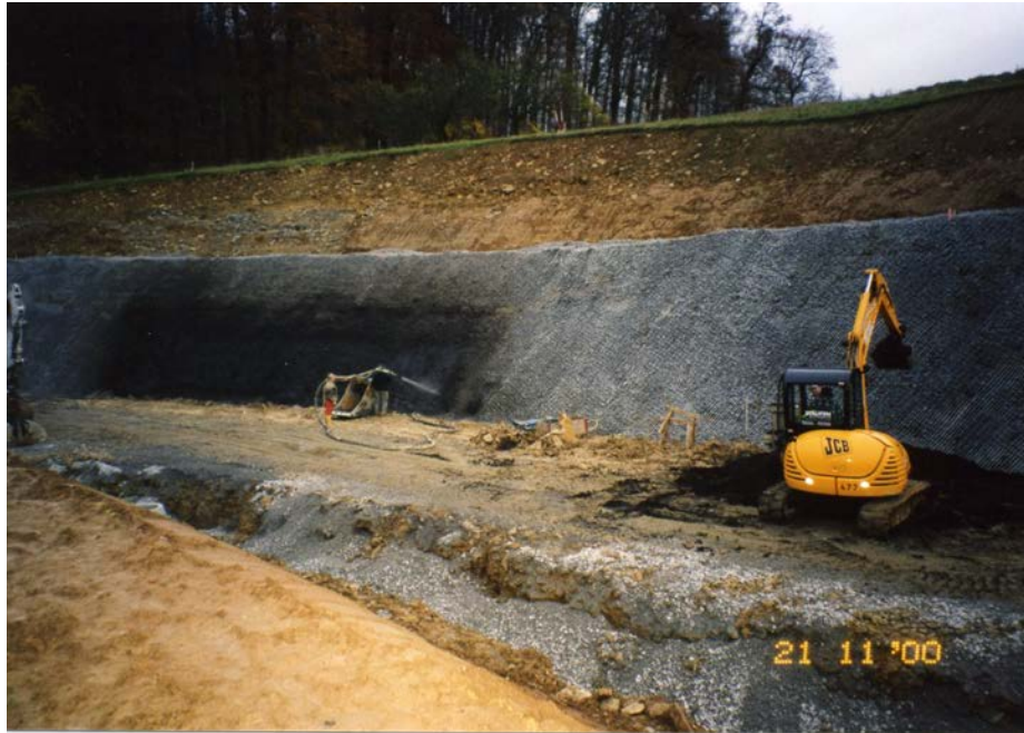
Fig. 6: Relleno de tierra vegetal mediante proyección
