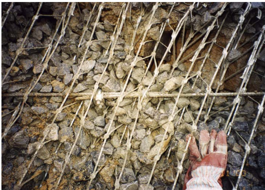
Fig. 5: Relleno parcial de grava
