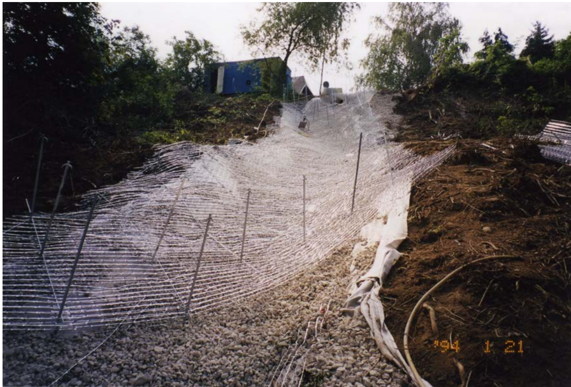
Fig. 5 Colocación en diagonal de la capa superior de malla J.K.S.
