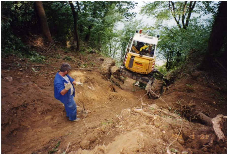
Fig. 2: Los trabajos de excavación de la zanja de drenaje y formación del embudo – los trabajos de llevaron a cabo con una excavadora todoterreno (araña) y en parte también de forma manual
