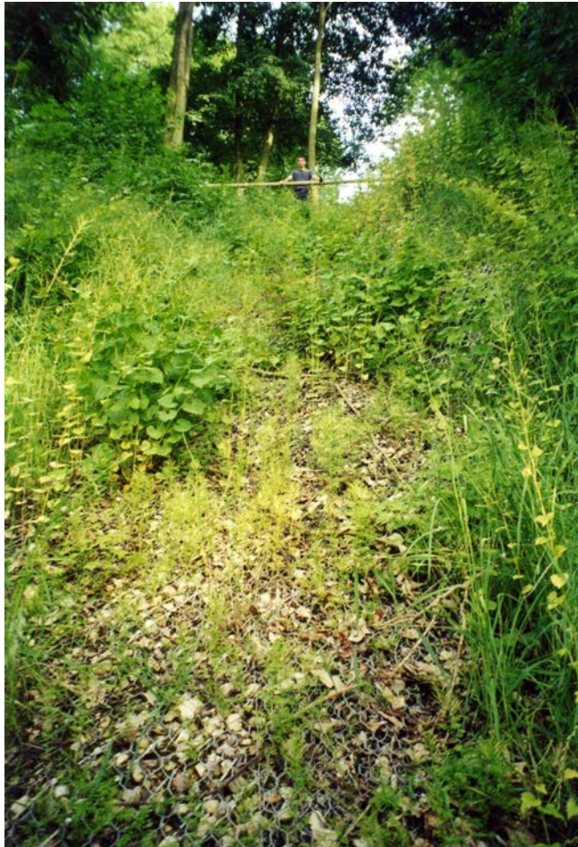
Fig. 8: Zanja de drenaje con el Sistema Krismer® (2000)
