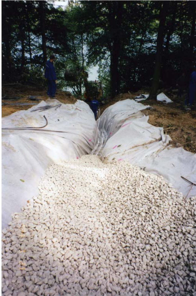
Fig. 3: Vista desde la carretera hacia el río Traun
