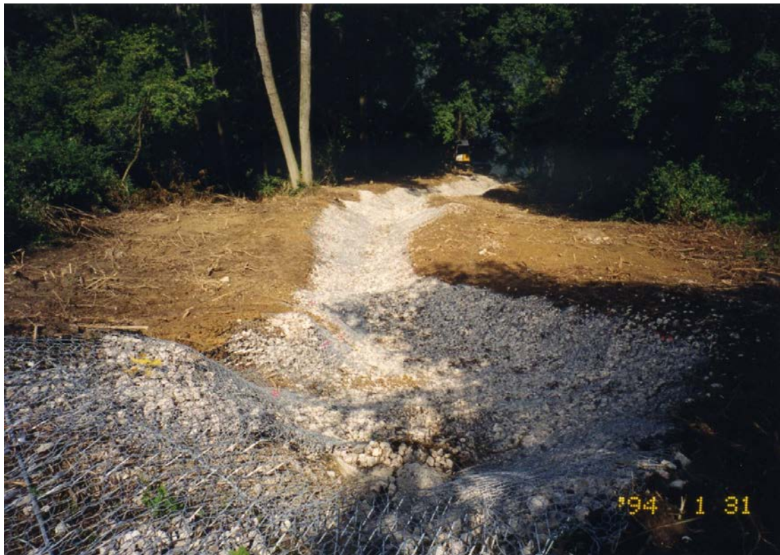
Fig. 6: Vista desde arriba hacia el río (zanja y embudo terminados; laterales revegetados y malla de cobertura fijada)
