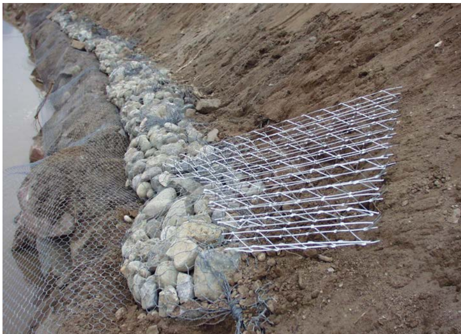
Fig. 5: Integración del Sistema Krismer® en la base del talud
