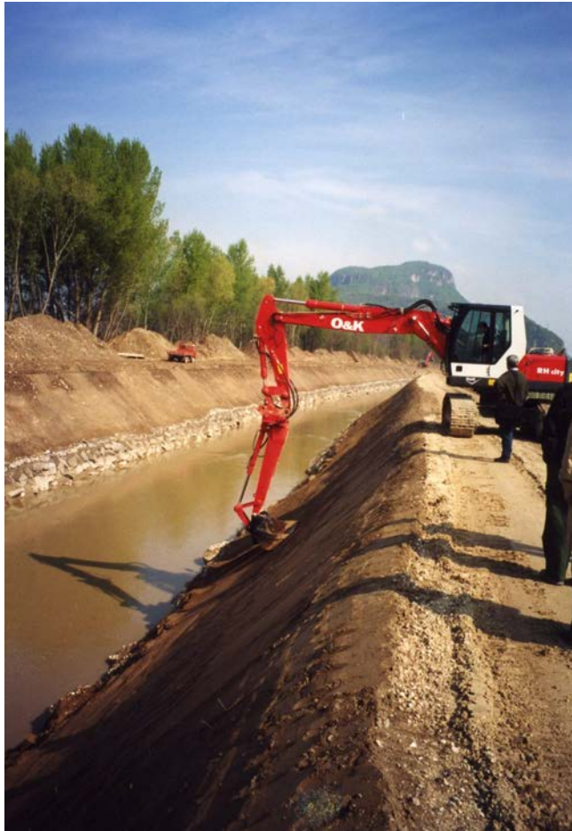
Fig. 12: Relleno con grava y tierra vegetal con retro excavadora y cazo de limpieza
