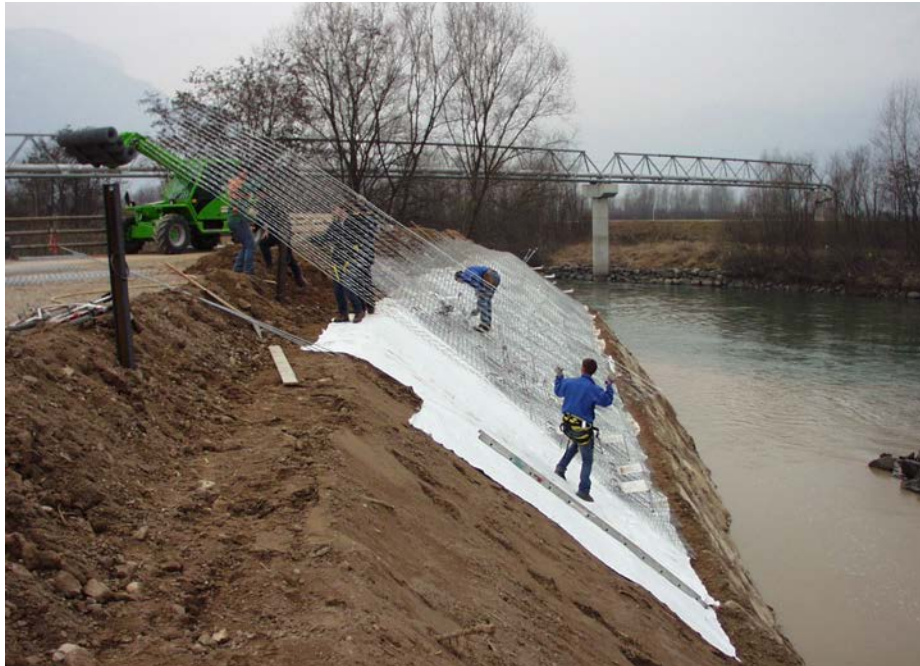
Fig. 8: Colocación de las filas de malla la malla tridimensional J.K.S.
