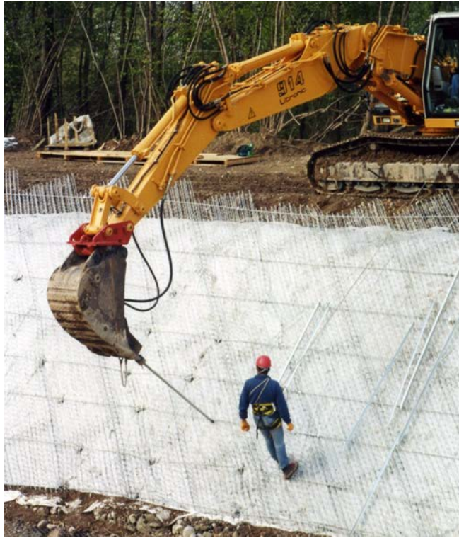
Fig. 10: Hincado de las puntas de anclaje
