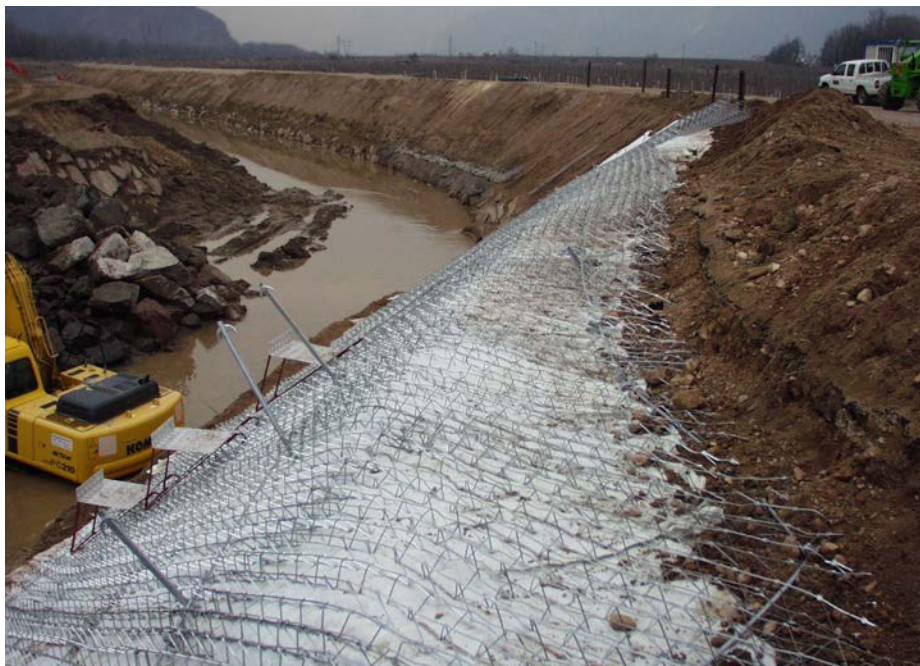
Fig. 11: Integración del Sistema Krismer® en coronación
