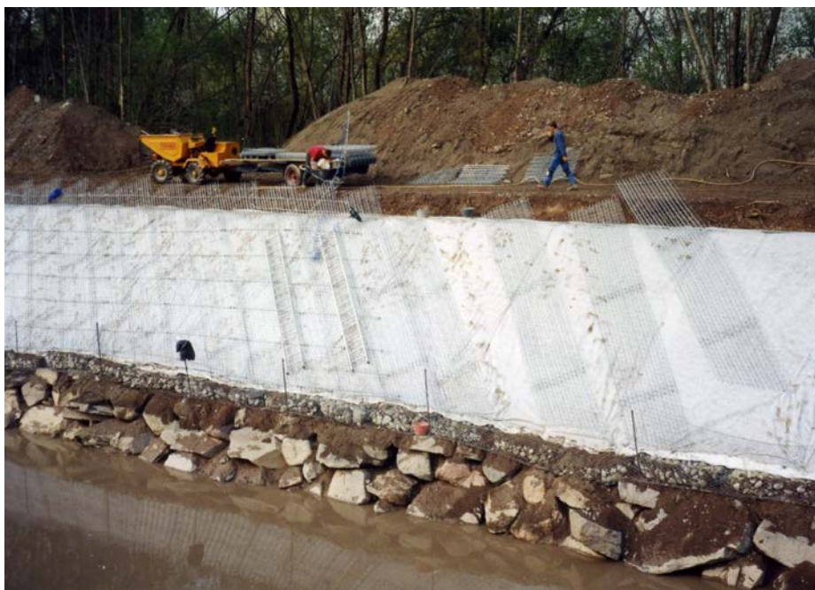
Fig. 9: Colocación diagonal de la malla J.K.S. en dirección opuesta a la del corriente del canal
