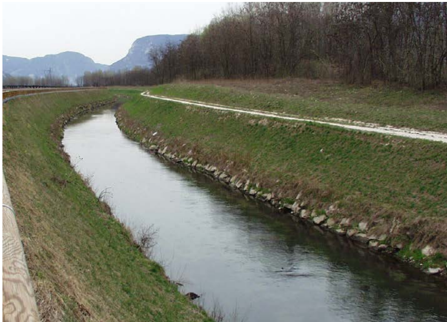
Fig. 14: Canal de drenaje principal de Branzoll (03/2004)
