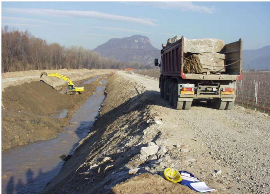
Fig. 3: Entrega de piedra para la construcción de la escollera
