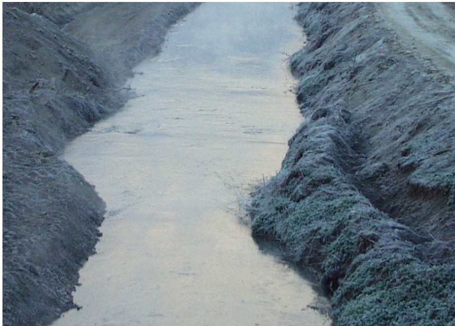
Fig. 1: Canal de drenaje principal de Branzoll, antes del inicio de los trabajos
