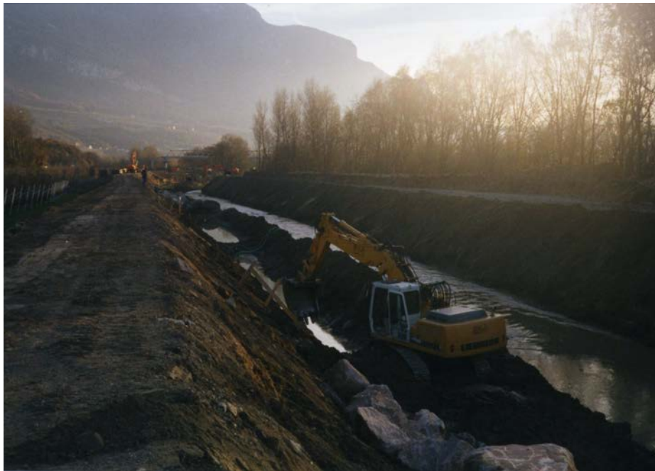
Fig. 2: Ensanchamiento del cauce existente y perfilado de los márgenes a la pendiente especificada en el proyecto
