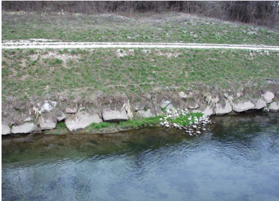
Fig. 13: Estabilización de márgenes con el Sistema Krismer® (03/2004)
