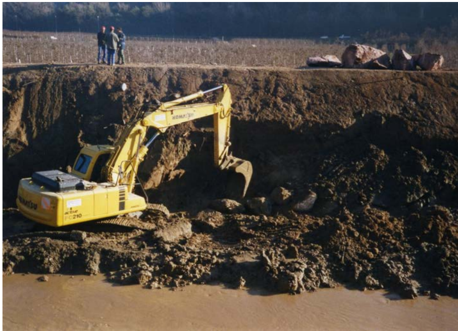
Fig. 4: Construcción de la escollera
