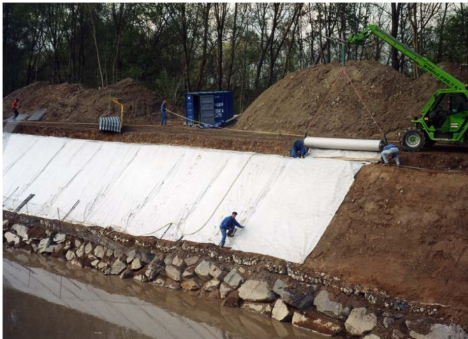
Fig. 7: Extensión del geotextil sobre toda la superficie
