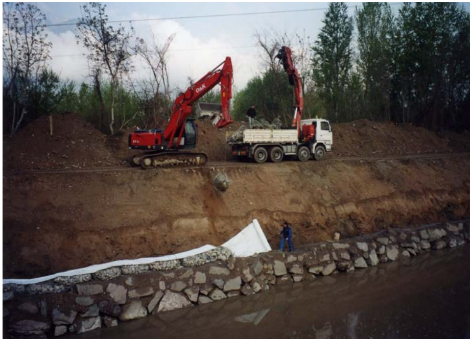
Fig. 6: Malla de triple torsión; geotextil y gaviones de saco, para la integración del Sistema Krismer® en la base de los márgenes
